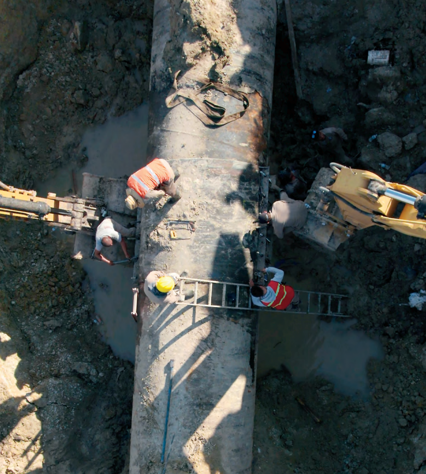
Ingenieros de SADM dando mantenimiento al Acueducto El Cuchillo I.
