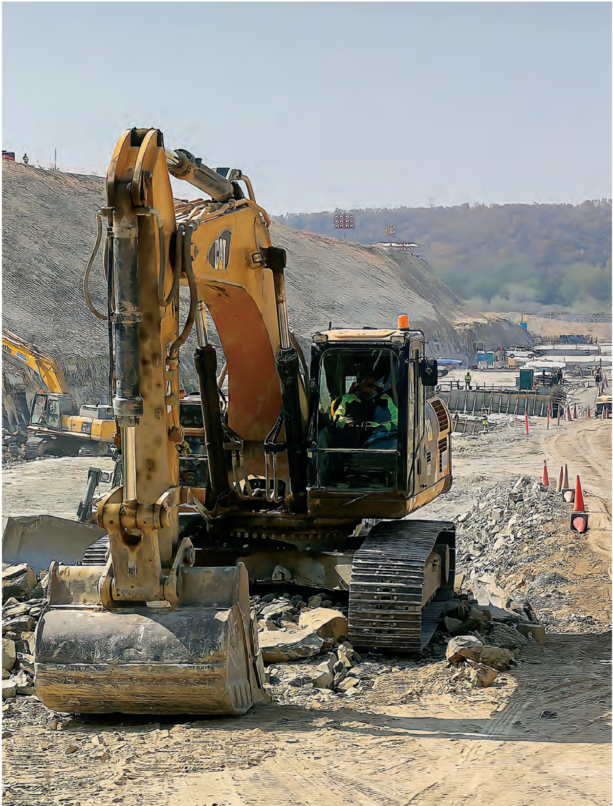
Rehabilitación de Carretera Monterrey-Colombia.
